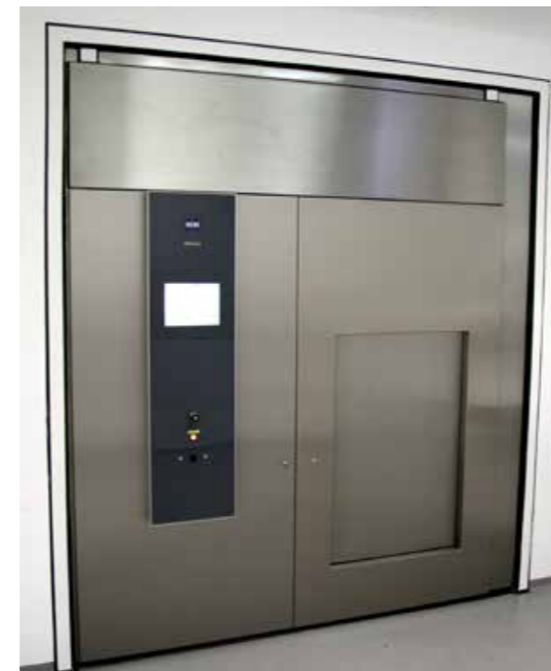
Cloisonnement étanche aux gaz
